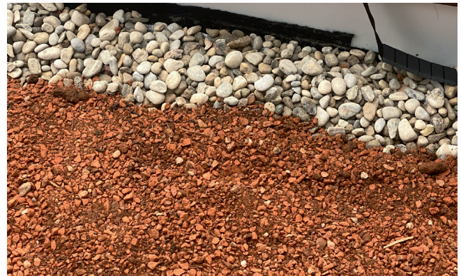
Recyliertes Material wird auch als Dachsubstrat verwendet.
